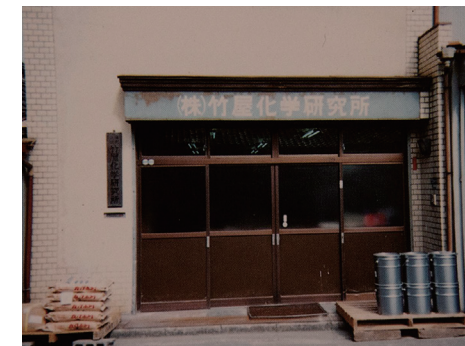
旧事務所兼工場(大阪府東大阪市)
