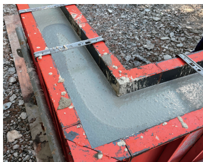
住宅建設時に使用するコンクリート 約17m 3
